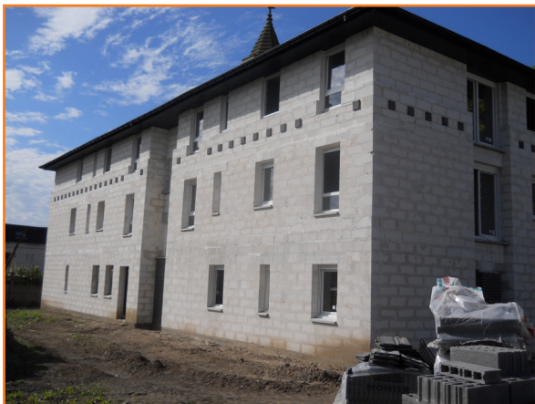
Chantier Sia Habitat rue Roger Salengro
